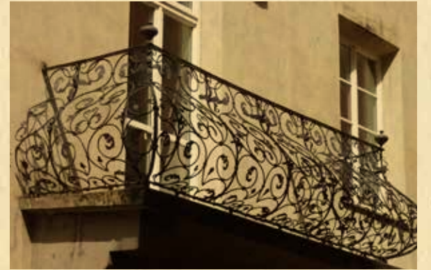
Vom Balkon des alten Rathauses wurden die Verlautbarungen an das Volk verkündet
